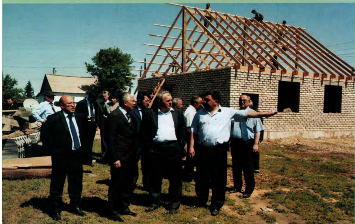
На строительной площадке хозяйства
