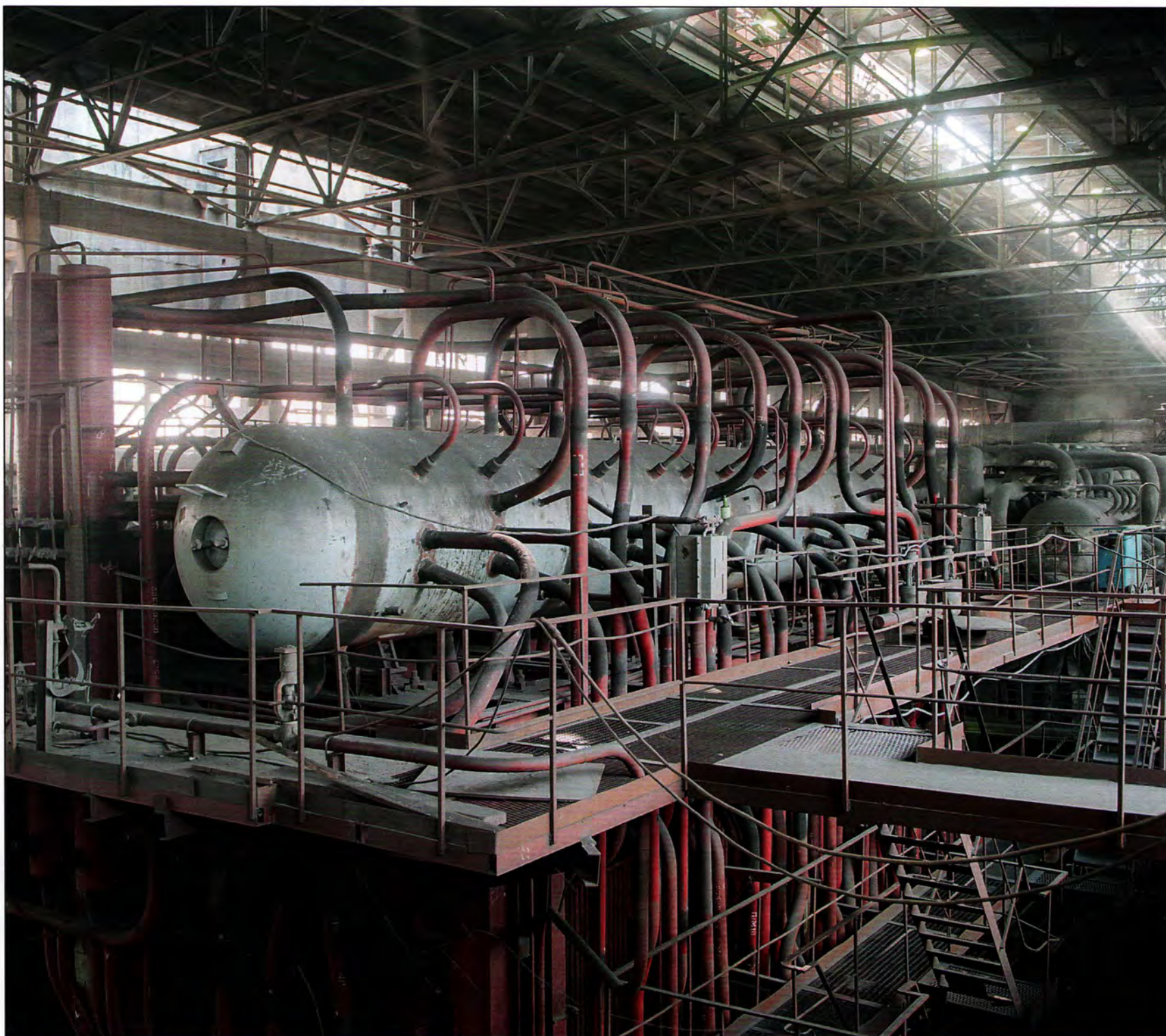
Котлоагрегат № 8 в процессе монтажа. 2013 год.
