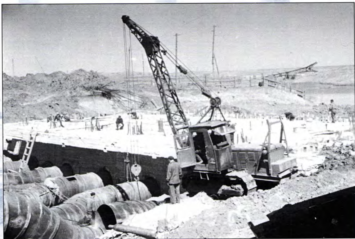
Строительство водовода ТЭЦ-2. 1960 год.
