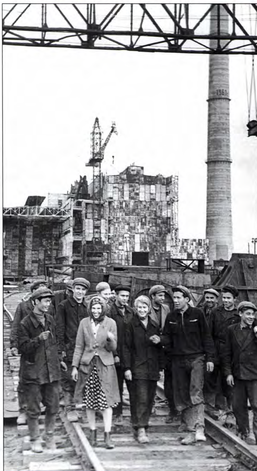
Энергетики и строители ТЭЦ-2. 1962 год.
