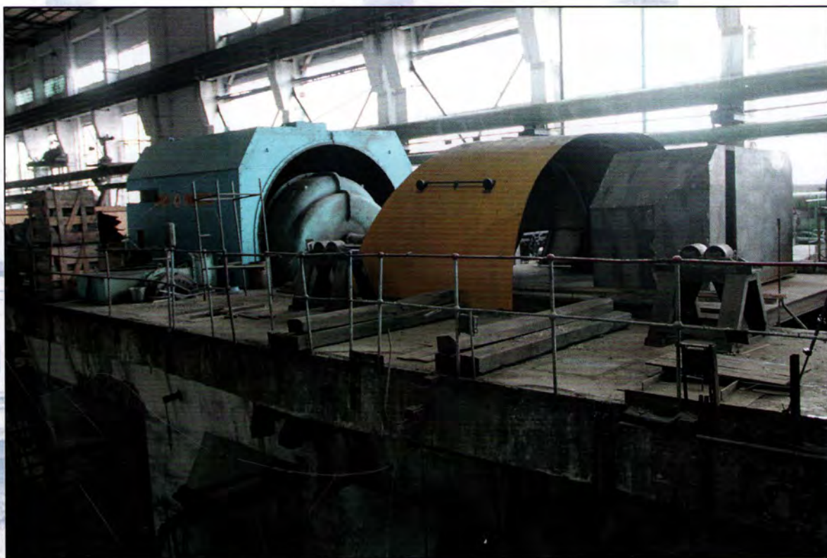
Начало демонтажа турбогенератора № 5. Октябрь 2014 года.
