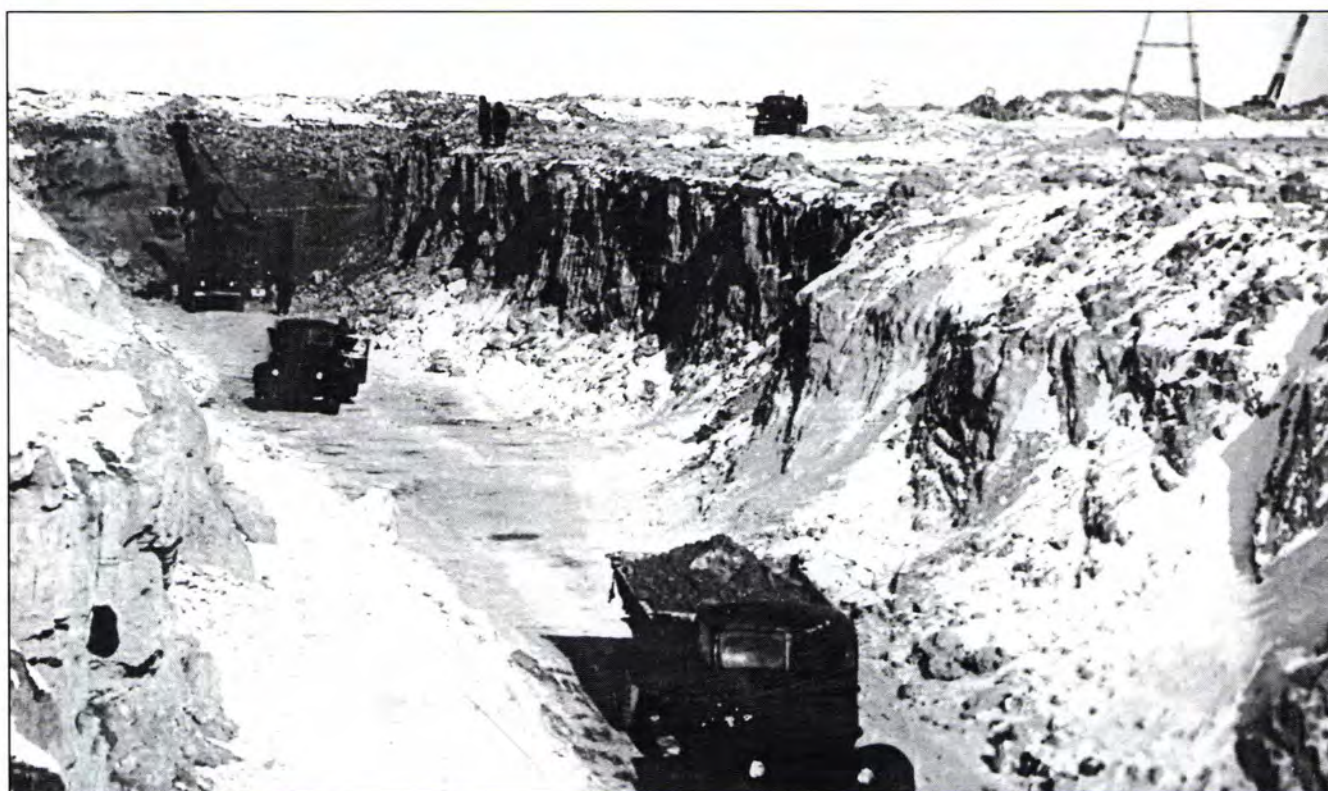
Строительство подводящего канала. 1958 год.
