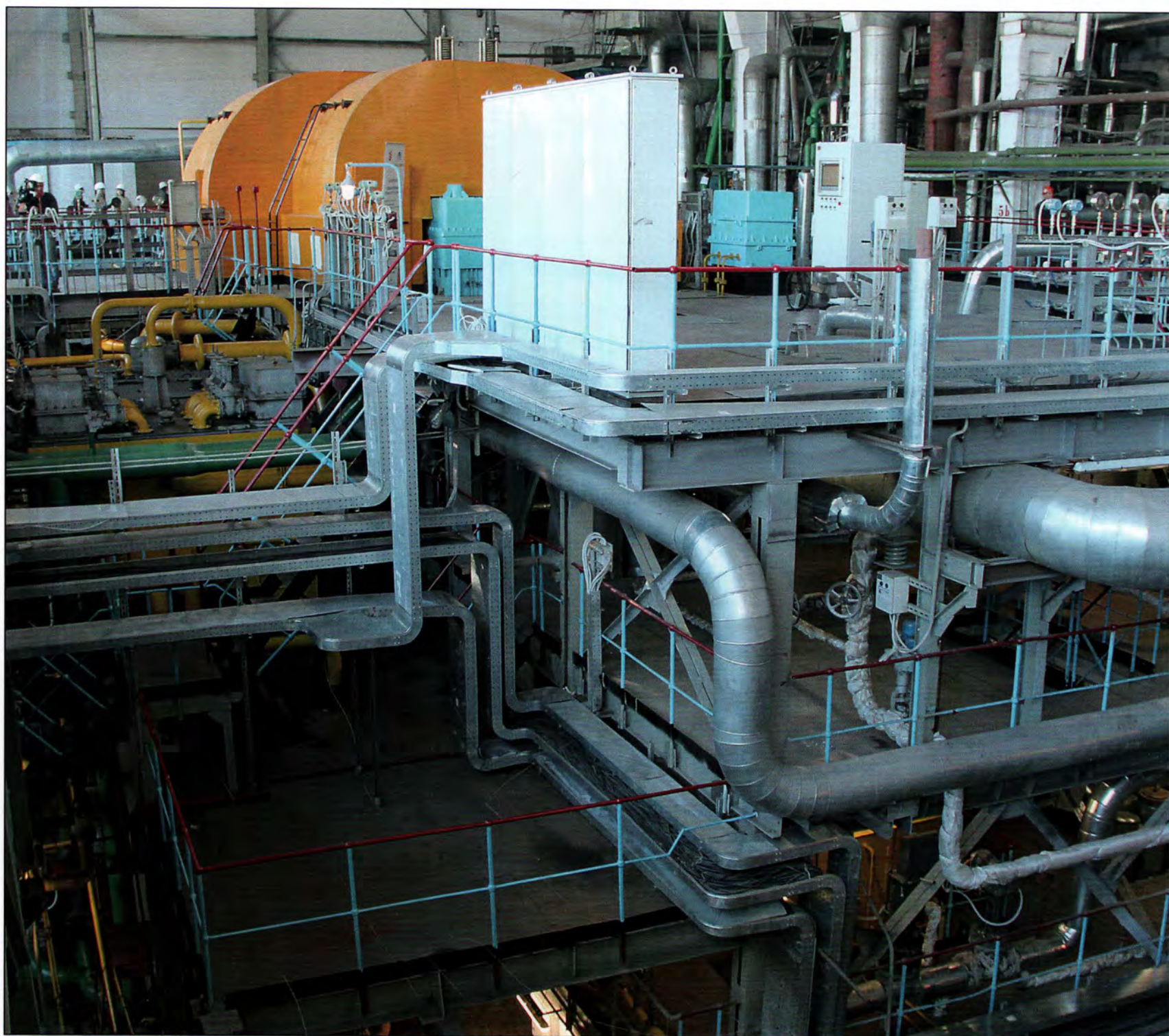
Турбогенератор №1 после полной замены. Сентябрь 2015 года.
