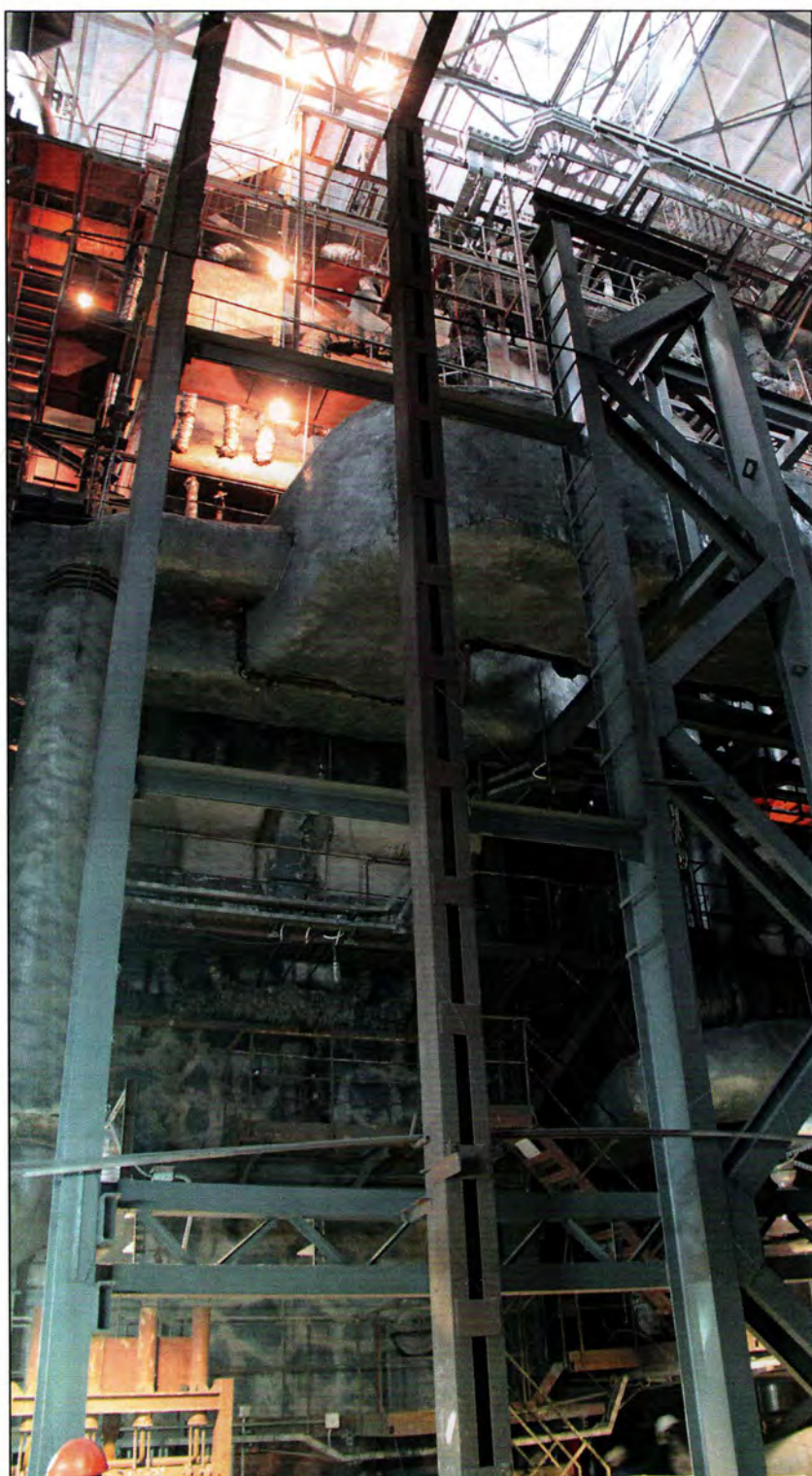
Модернизация котлоагрегата № 8. Сентябрь 2014 года.
