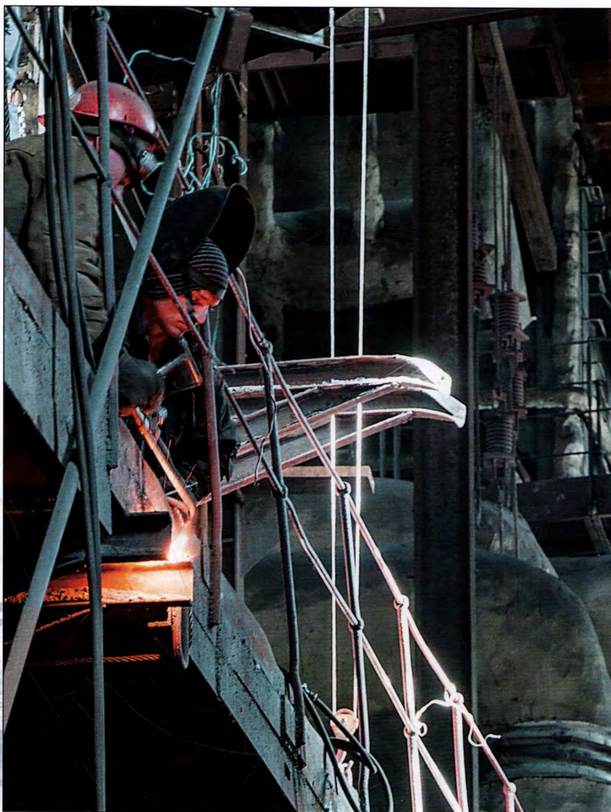
Реконструкция в котельном цехе. 2012 год.
