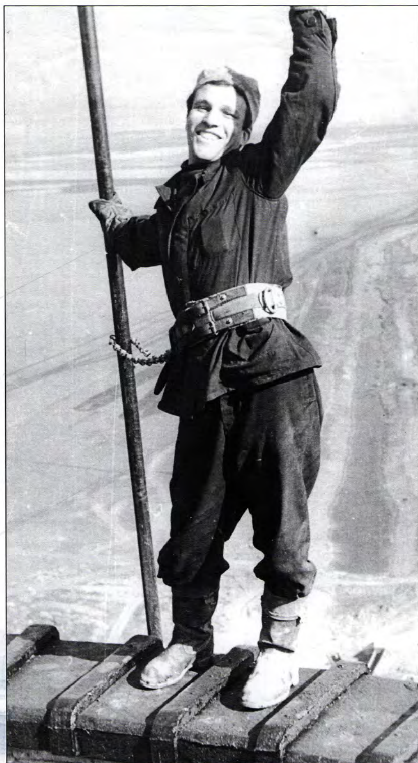
Установлена высота дымовой трубы 152 метра. 1961 год.
