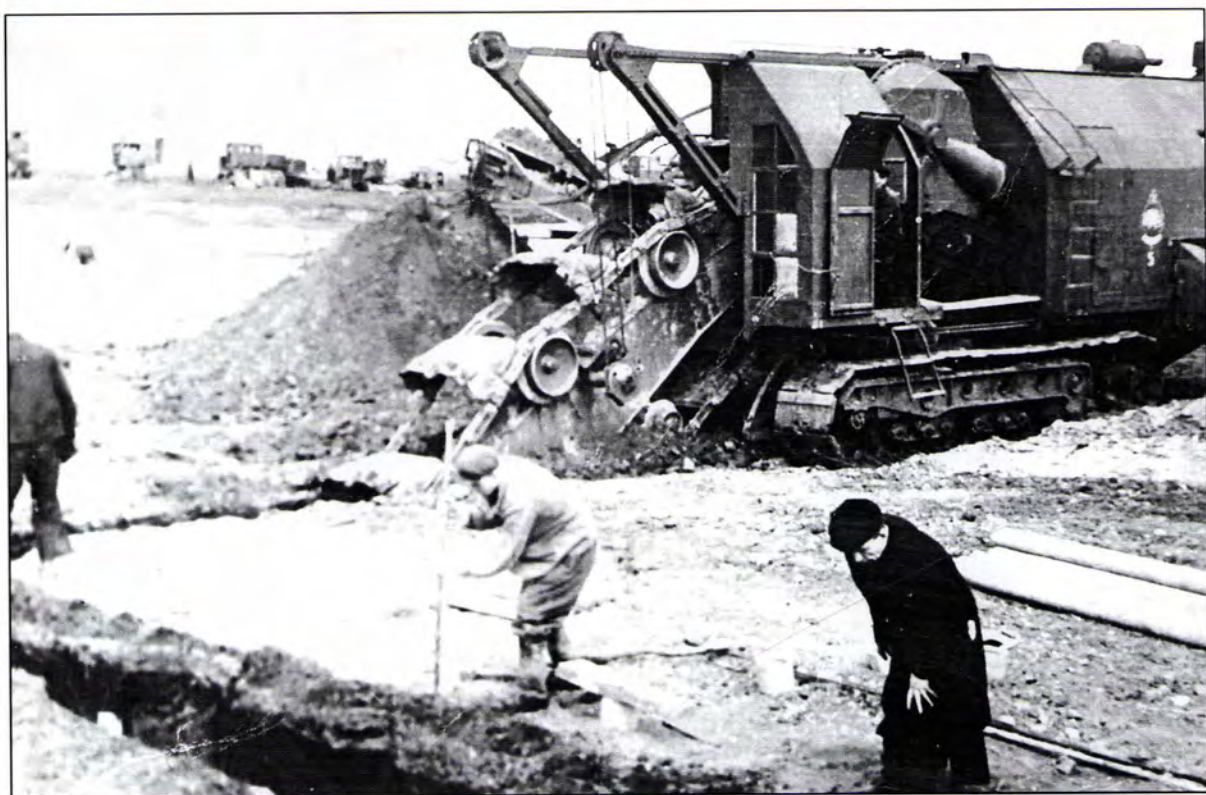
Прокладка водопровода. 1960 год.
