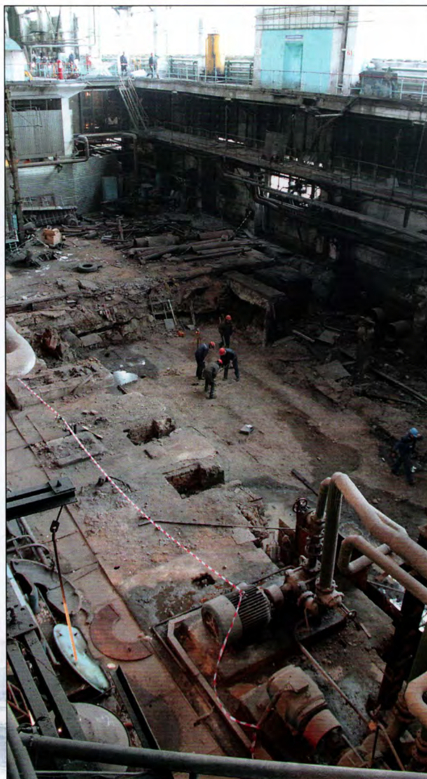
Демонтаж старого фундамента турбогенератора № 1. 2014 год.
