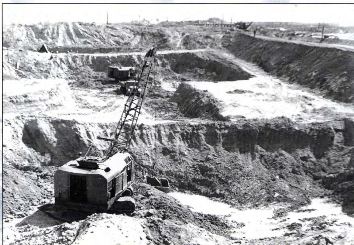
Строительство котлована под вагоноопрокидыватель. 1962 год.
