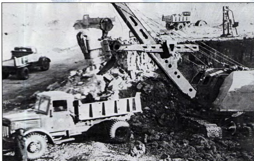
Первые кубометры грунта на трассе отводящего канала. 1958 год.
