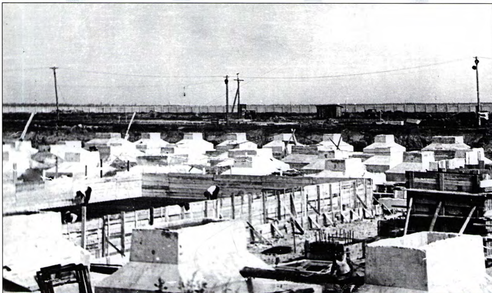
Железобетонные стаканы фундаментов. 1959 год.
