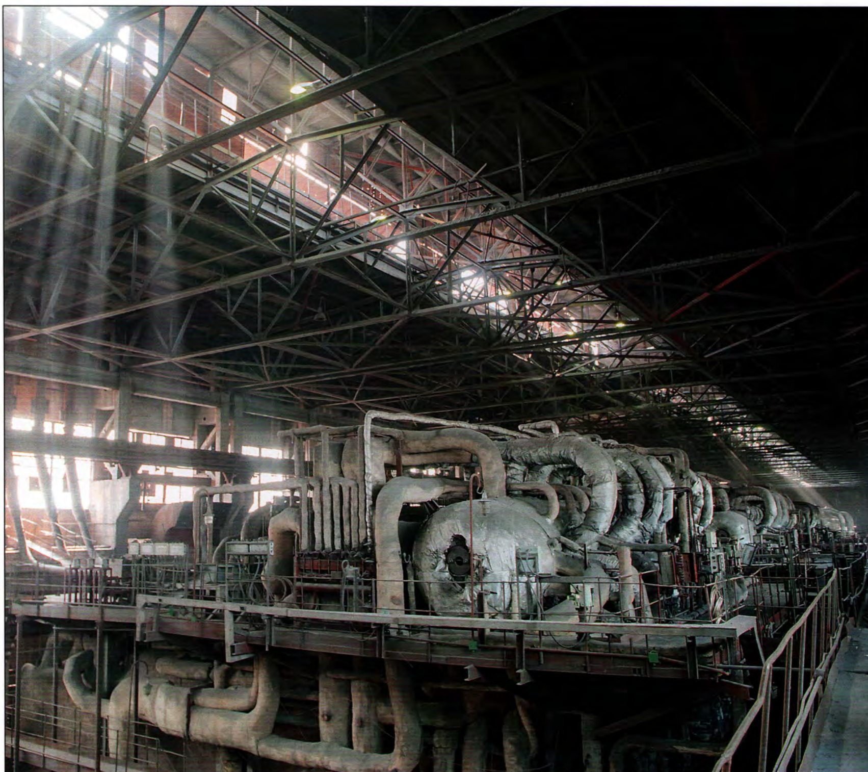
Котельный цех. 2013 год.
