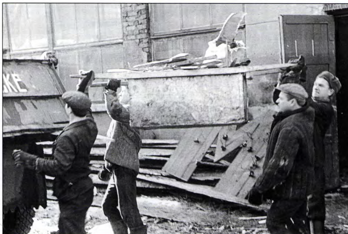
Погрузка древесных отходов. Субботник. 1971 год.
