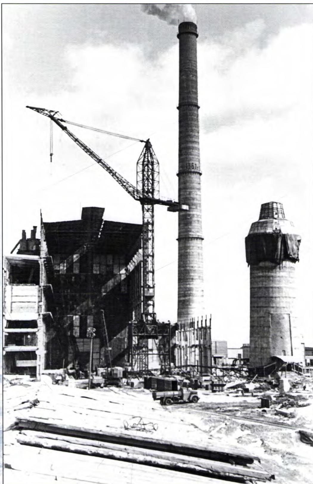
Строительство дымовой трубы № 2. 1963 год.
