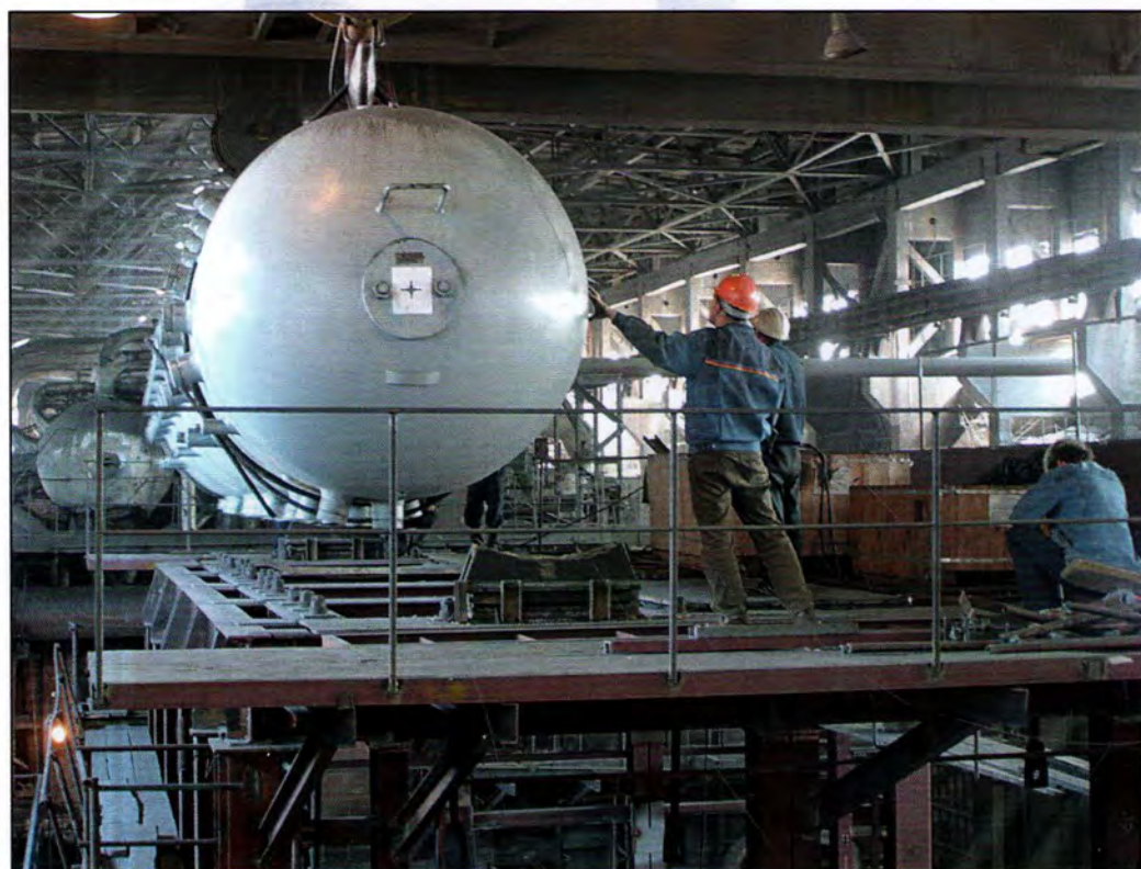
Установка барабана котлоагрегата № 7. 2012 год.
