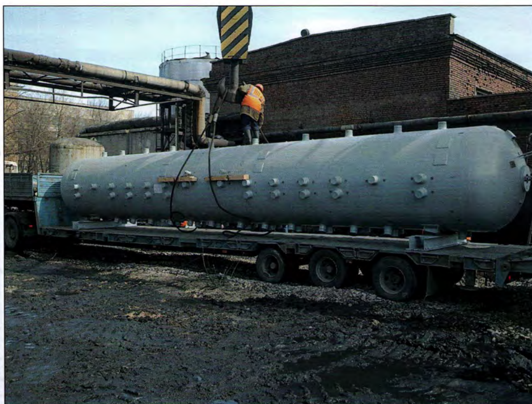
Выгрузка барабана котлоагрегата № 7. Март 2012 год.
