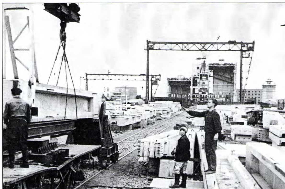
Погрузка стройматериалов. 1961 год.
