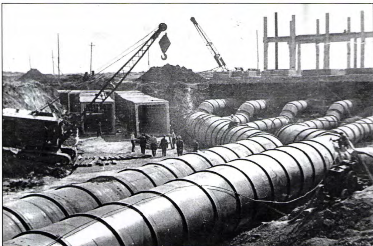
Монтаж сбросного канала. 1961 год.
