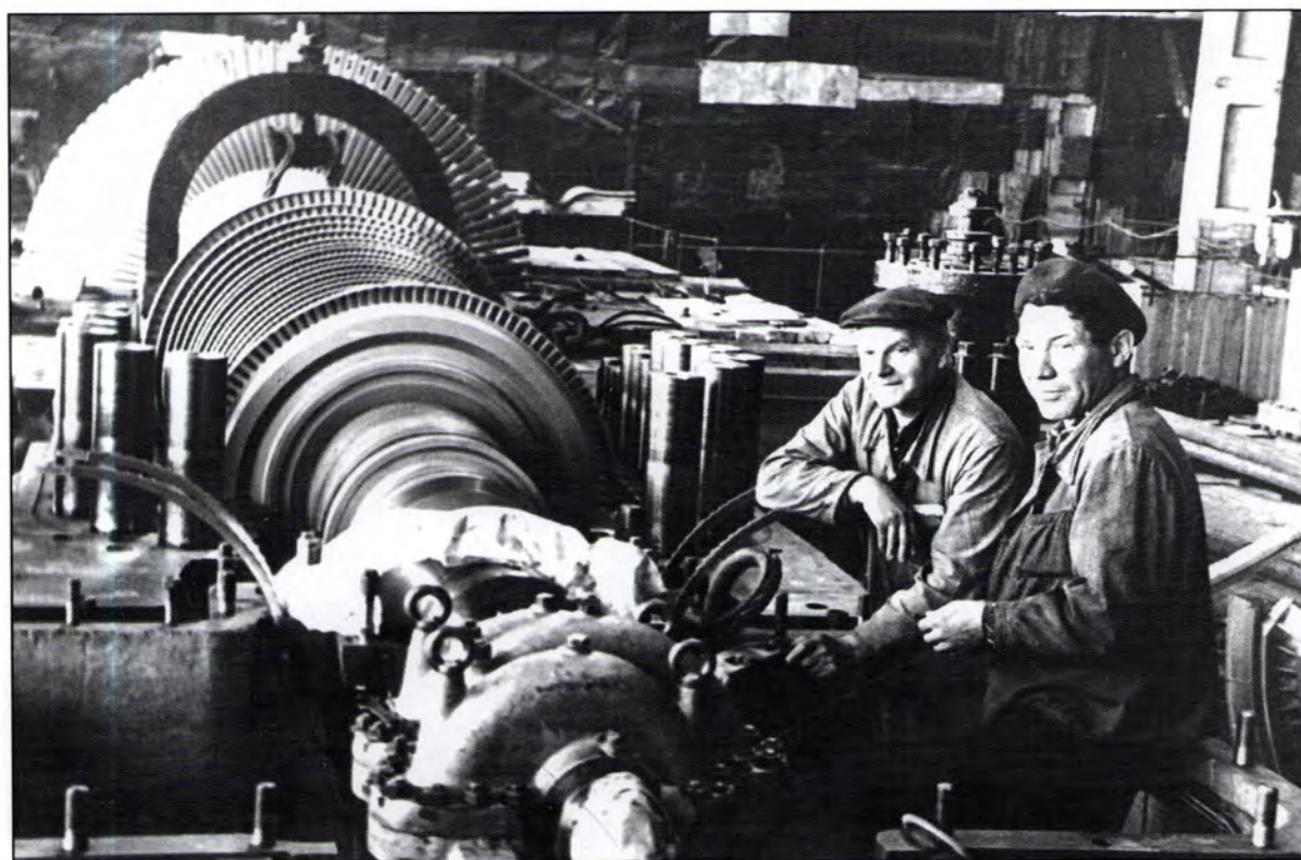
Монтаж турбогенератора № 7. 1969 год.
