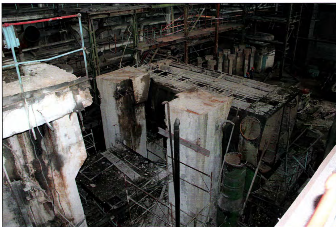
Демонтаж турбогенератора № 1. Август 2014 года.
