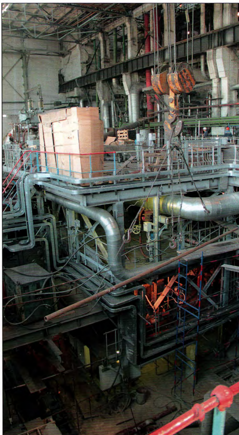
Модернизация турбогенератора № 1 на ТЭЦ-2. Июль 2015 года.
