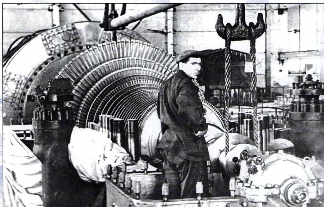
Монтаж турбогенератора №1. 1961 год.
