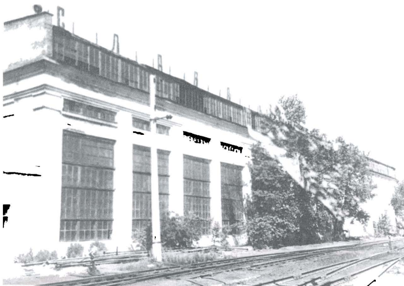
Депо Петропавловск. Цех подъёмки тепловозов
