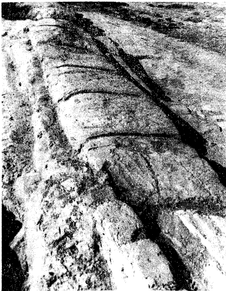
Рис. 20. Пахсовая кладка стен цитадели Куйрук-тобе. VII — первая половина IX в.
