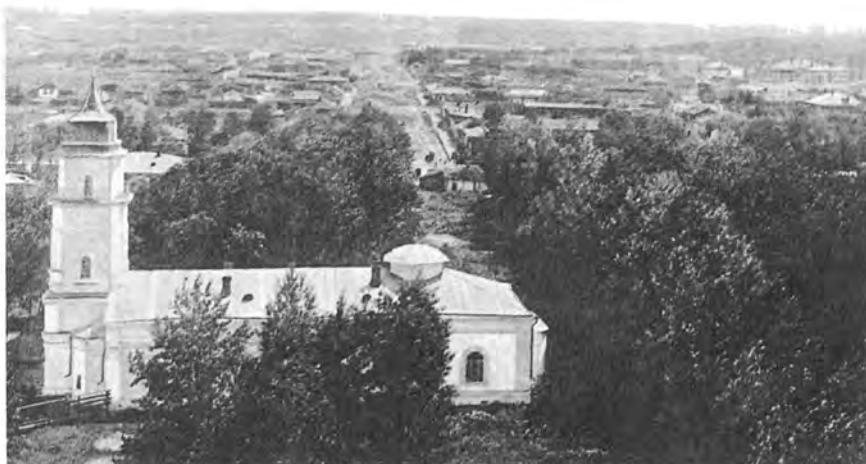
Подгорная мечеть Петропавловска, построена в 1795 году.
